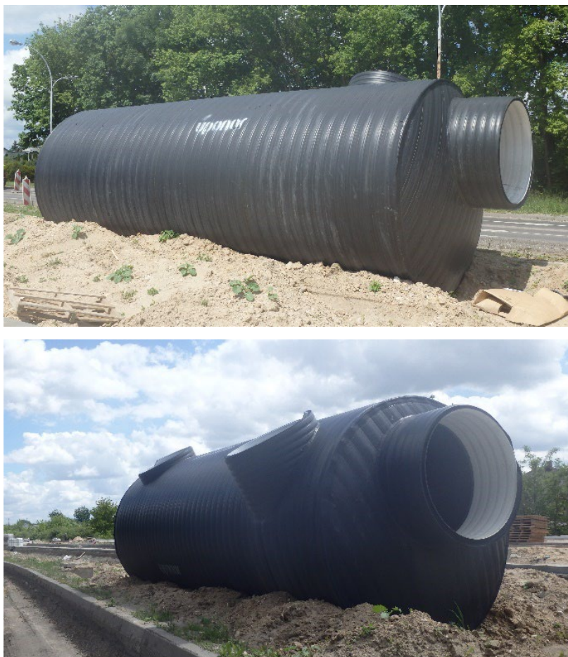
Rys. 2-1 Zbiornik z HDPE DN2400 przed montażem na terenie inwestycji (fot. Dąbska A.)
