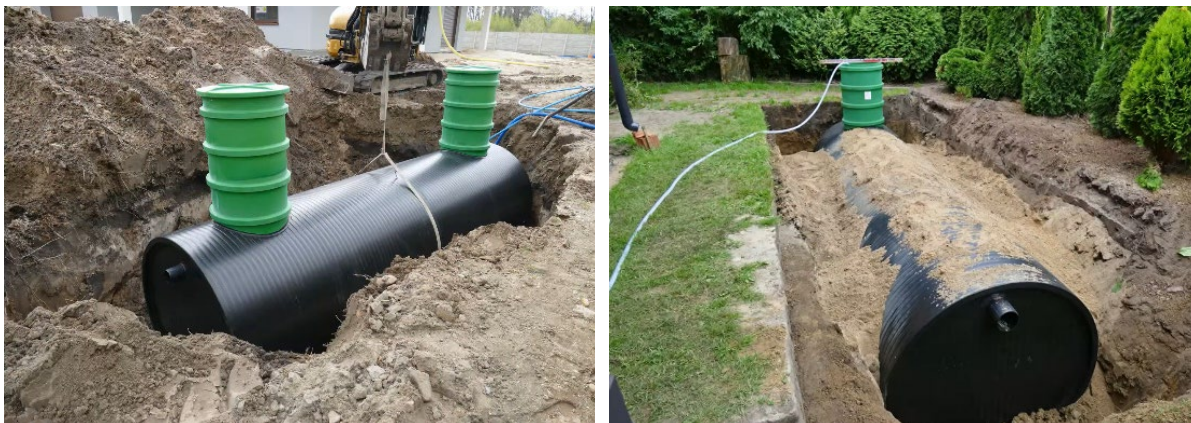
Rys. 2-6 Zbiornik dwupłaszczowy z dennicą płaską podczas montażu w wykopie (Wobet-Hydret Zbiorniki bezodpływowe, 2016)
