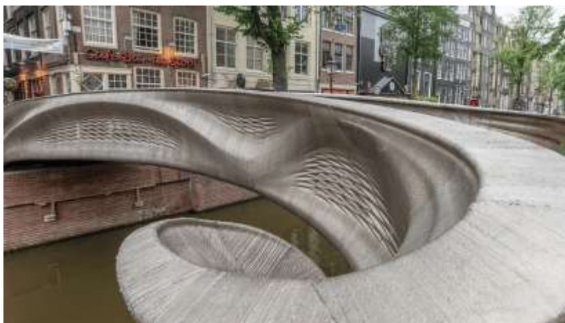
Rys. 1.3 Most w Amsterdamie ze stali nierdzewnej wytworzony metodą WAAM [8]
