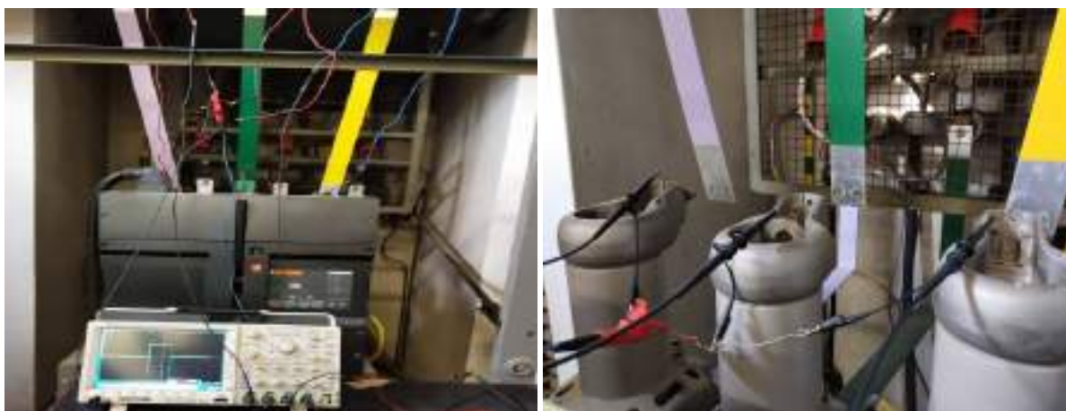
(a) widok od frontu panelu wyłącznika MV CB.
