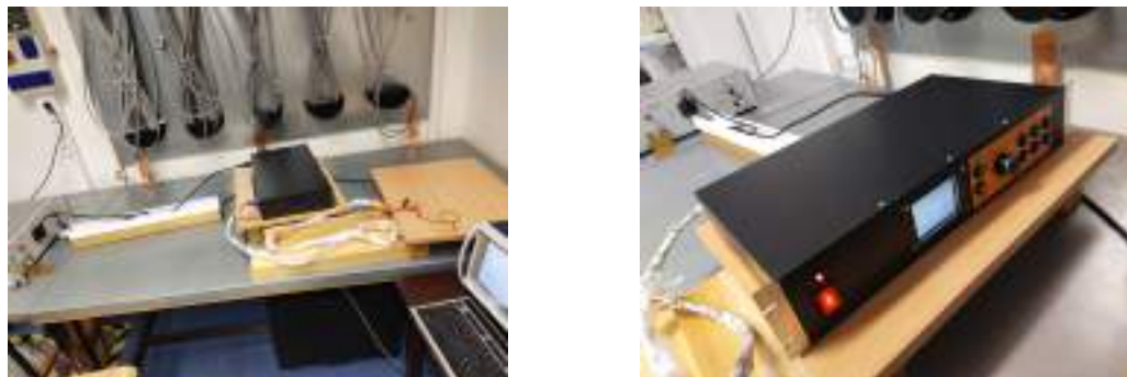
Rysunek 9.5. Nowy nastawnik w trakcie badania radioelektrycznej emisji przewodzonej.
